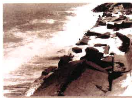
S43. 駿河海岸 大井川工区被災状況
