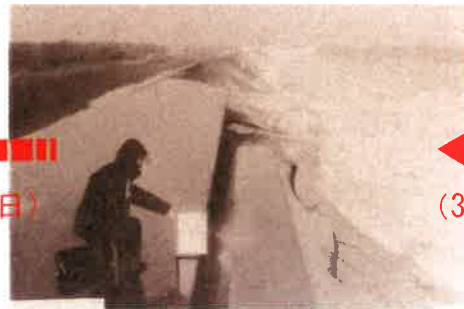
●S47. 10. 30 15:45 堤防欠壊が拡大
