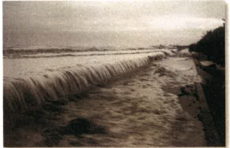
S54 駿河海岸 大井川工区 越波状況
