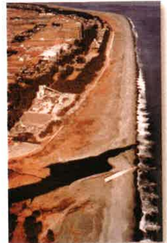
S53 焼津工区
