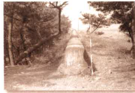
S44 焼津工区 破堤状況
