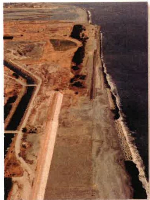
S58 川尻工区の状況
