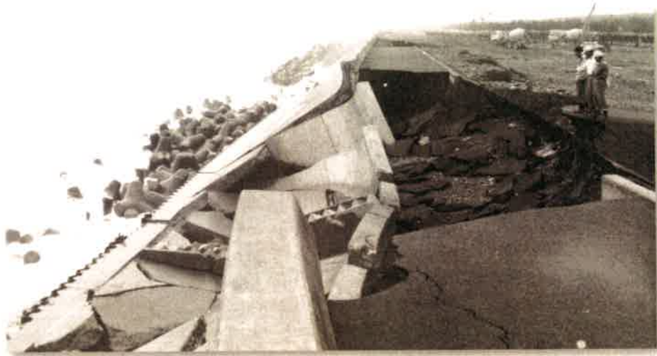
S47. 7. 23 台風9号 堤防破堤状況
