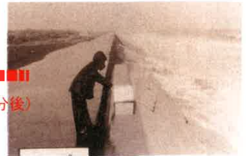
●S47. 10. 30 15:08 堤防欠壊始まる
