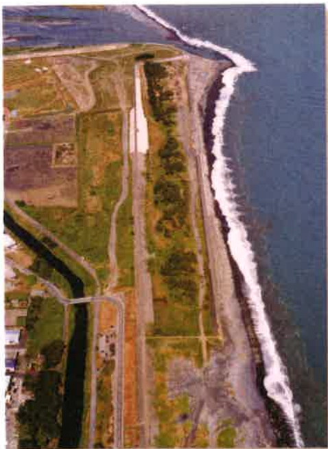
H14 川尻工区の状況
