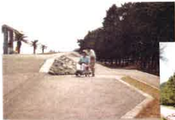
緩傾斜スロープ
