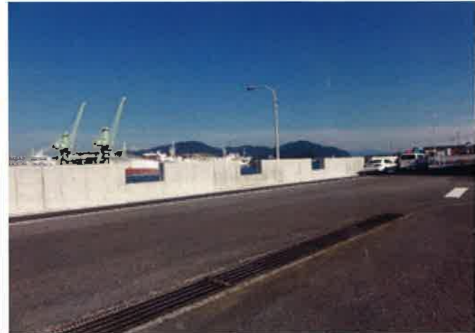
進行する小川港の津波対策の胸壁工事
