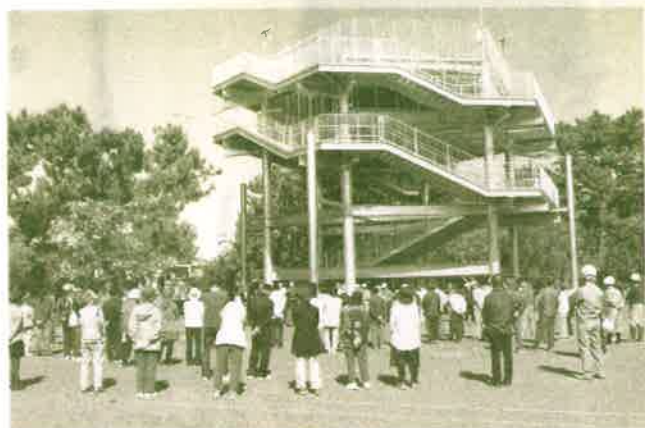
石津浜避難タワー完成に集まった地区住民（H25.4.28）
