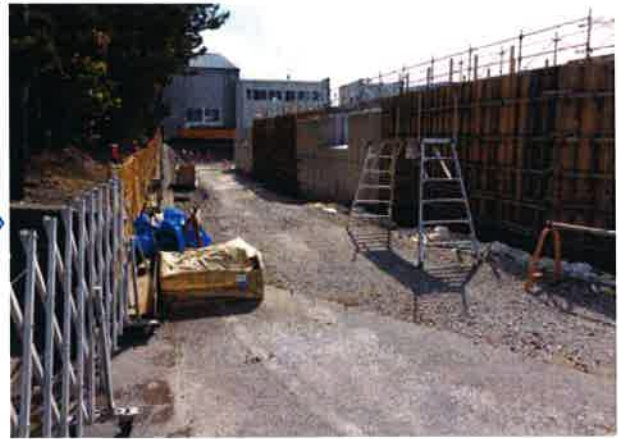
施工中 (胸壁本体工)
