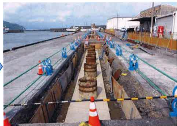
施工中 (基礎杭工)
